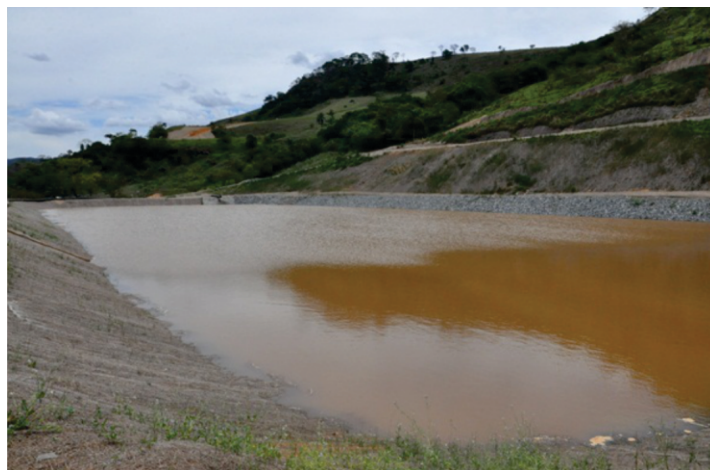
A água proveniente do dique principal passará por tratamento em três bacias antes de retornar ao rio
