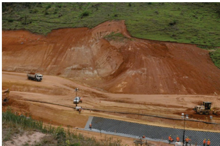
Deslocamento no terreno do dique intermediário inviabilizou sua utilização
