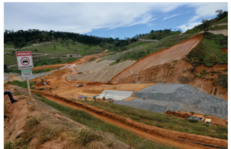
Dique principal: local onde será construída a nova barragem
